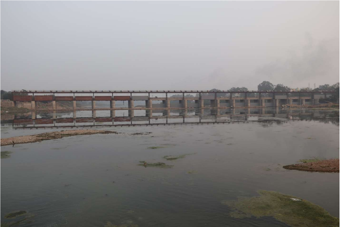
अरपा नदी पर निर्माणाधीन पचरीघाट बैराज
