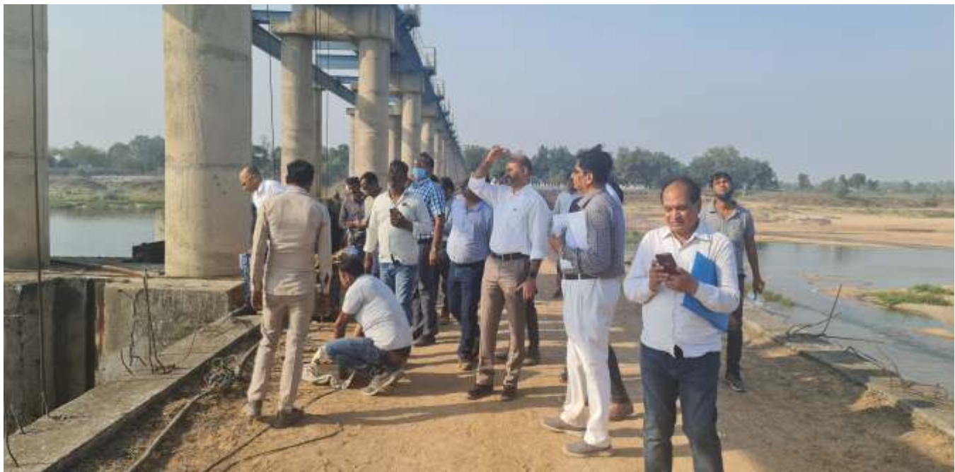
श्री अन्बलगन पी., सचिव, जल संसाधन द्वारा निर्माणाधीन शिवरीनारायण बैराज का निरीक्षण
