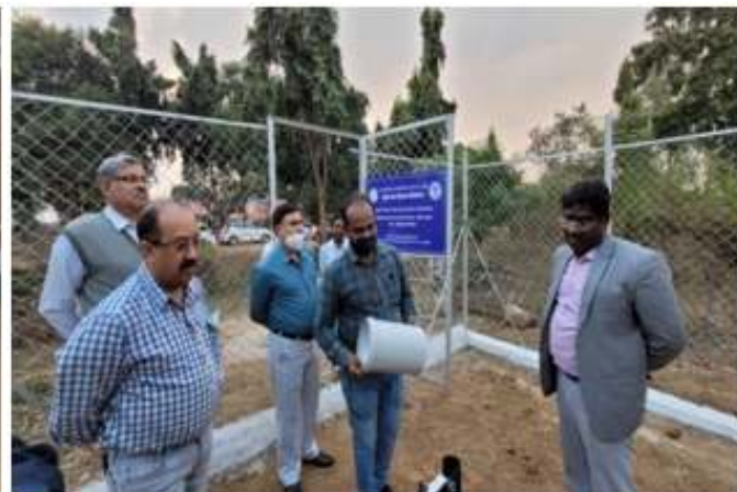
श्री डी. गननसुन्दर, SJC NHP द्वारा कोडार बांध स्थल में RTDAS के अंतर्गत स्थापित किये जा रहे स्वचालित उपकरणों का स्थल निरीक्षण
