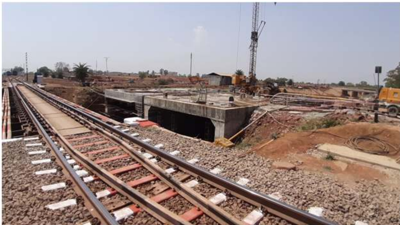
महानदी मुख्य नहर के कि.मी. 83.35 पर लखौली (आरंग) रेल्वे स्टेशन के समीप रेल्वे ब्रिज निर्माण कार्य
